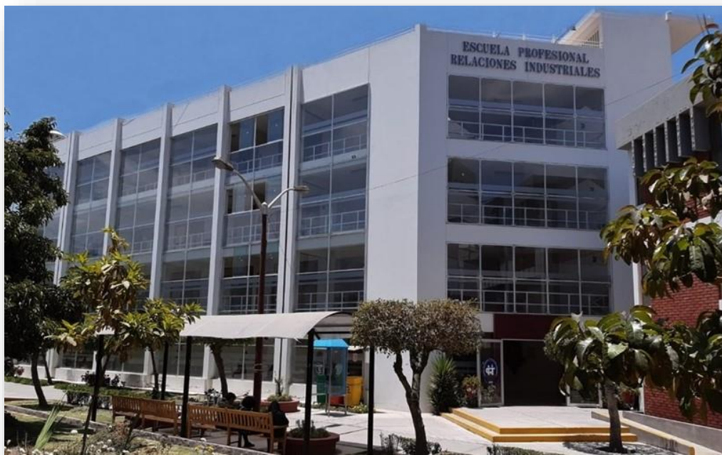
Vista exterior de las instalaciones de la Escuela Profesional de Relaciones Industriales
